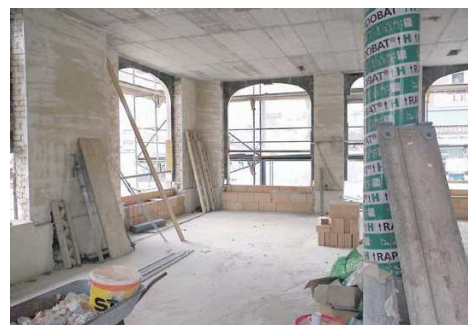
Noch ist das Erdgeschoss im »Grünen Haus« eine Baustelle. Hier wird schon bald das »Café Horizont« entstehen.
