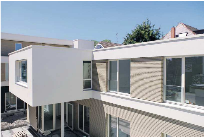
Um den Innenhof zur bestehenden Villa Wetzstein wurde hier ein Ort der Würde erschaffen.
